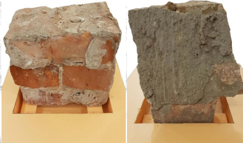
Фрагмент кирпичной кладки до начала исследования
